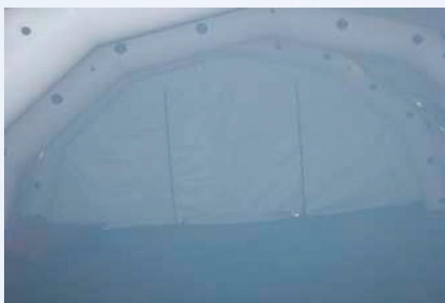
Interno tenda riscaldata da generatore di aria calda con temperatura aria in uscita superiore a 100°C senza dispositivo controllo temperatura.
